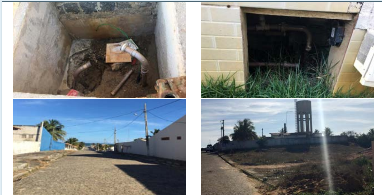
Figura 02 – Observação da realidade do esgotamento sanitário no Povoado Caueira
