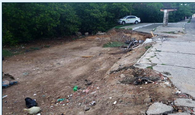
Figura 06 – Más condições das calçadas que atuam como elemento delimitador das APPs
