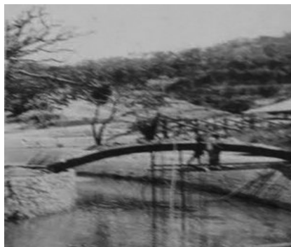
Figura 3. Obras já finalizadas. Fonte: Jornal Gazeta de Sergipe nr: 7.864 - 21/01/1985.
